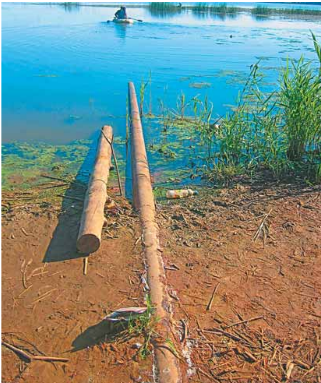
Рис. 3. Труба для сброса избытка добытых минеральных вод в санатории «Тараскуль»
